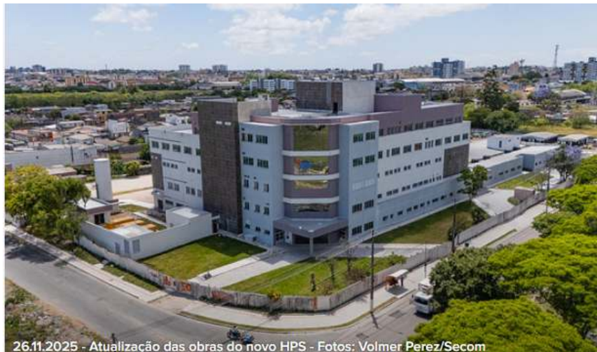
26.11.2025 - Atualização das obras do novo HPS - Fotos: Volmer Perez/Secom
